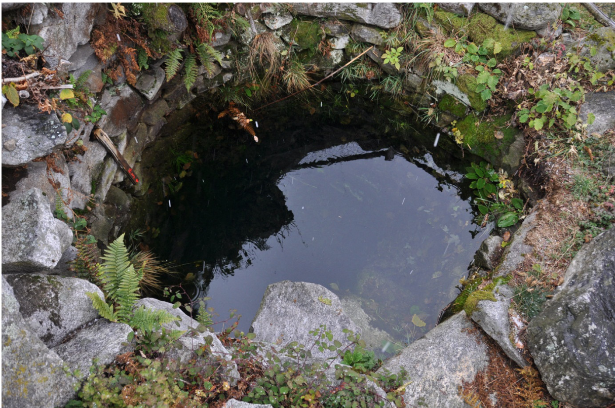
Abb. 3 Zisterne mit einem Fassungsvermögen von 12'000 Liter Wasser auf Ar Cistérna
